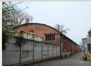
Le hangar (bâtiment 102) côté Poste
